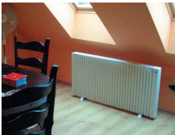
Montáž topných panelů Mirava v prostoru pomocí stojanů
