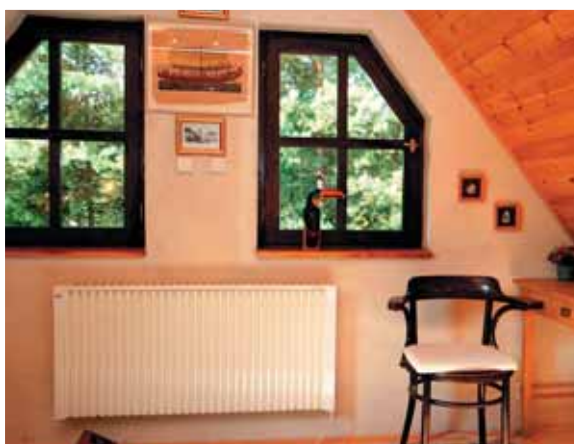
Montáž topných panelů Mirava na zeď
