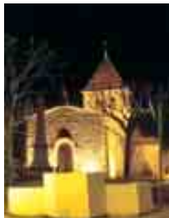
Osvětlení veřejných budov
