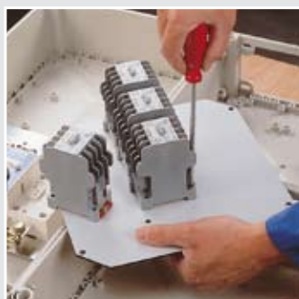
Přístroje se upevní na montážní desku pomocí samořezných šroubů.
