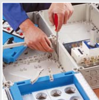
Držák Mi EP 02 pro uchycení krycí desky se přišroubuje na dno skříně.
