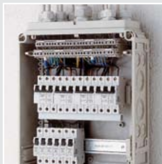
PE a N svorky pro Cu vodiče
