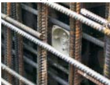
Víčko KBV připevněné na bednění.
