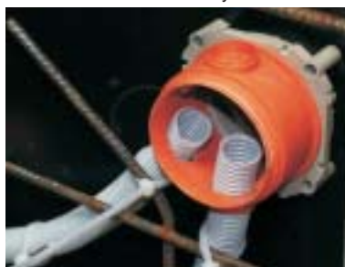
Namontované ohebné trubky do tělesa KBT.
