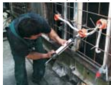
Utěsnění prostupů (tmel).
