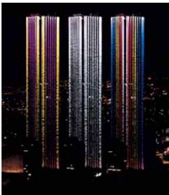
Světelná podívána s XBO® 3 a 4 kW. Ve světlometech na střeše okouzluje hry barev na 200 metrů vysoké fasádě Bogotá Tower v Kolumbii.
